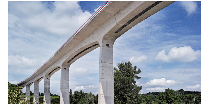
Aurachtalbrücke, Entwurf: SSF Ingenieure AG, Foto: Florian Schreiber Fotografie
