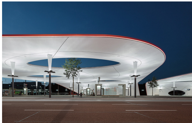
Zentraler Omnibusbahnhof Pforzheim, Planung: METARAUM Architekten BDA, ENGELSMANN PETERS GmbH, Foto: zoey braun Fotografie
